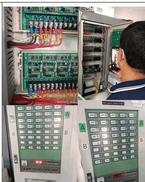
ภาคผนวกที่ 3.48 จัดให้มีการซ่อมบำรุงรักษาอุปกรณ์ ป้องกันและสัญญาณเตือนอัคคีภัย
