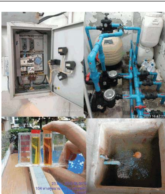
ภาคผนวกที่ 3.41 จัดให้มีเจ้าหน้าที่ตรวจสอบระบบและทำ ความสะอาดกรองสรว่ายน้ำ
