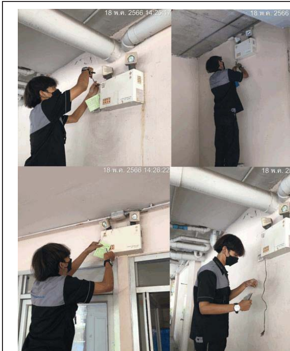
ภาคผนวกที่ 3.21 ตรวจสอบอุปกรณ์ไฟฟ้าสำรอง
